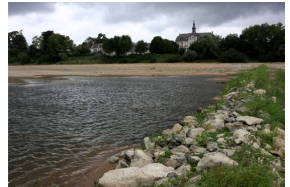
Un épi au travers du fleuve, à Béhuard
