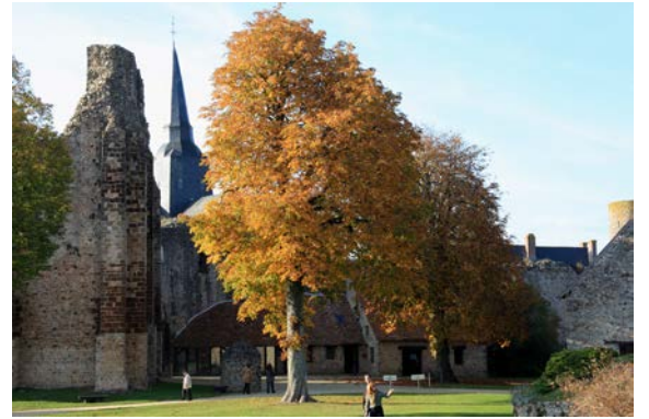
Le parc du château du 17 e siècle
