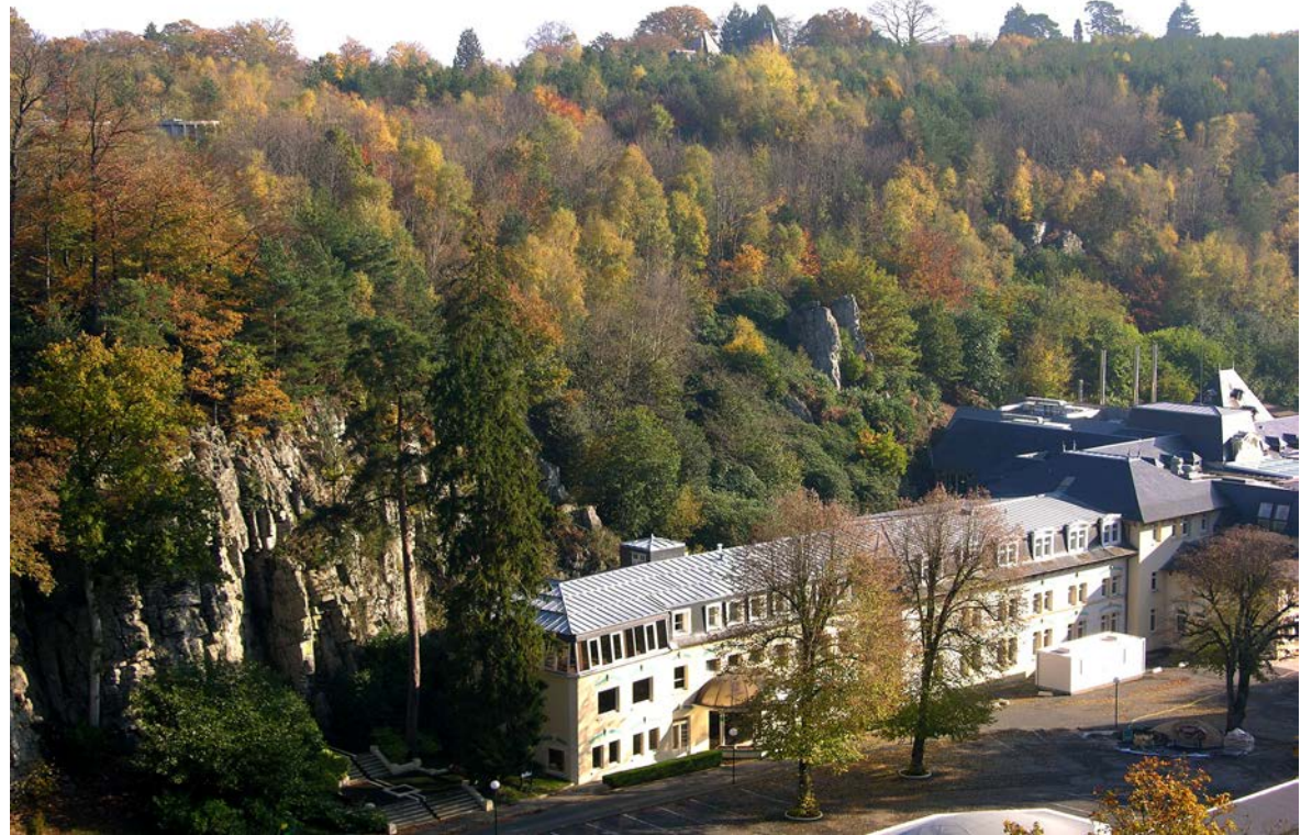
L'établissement des Thermes dans Bagnoles-de-l'Orne
